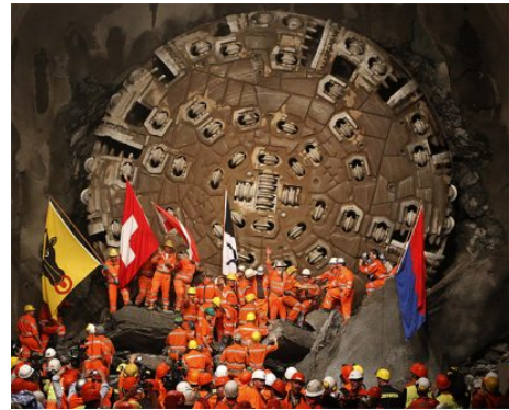
Abb. 1: Der Durchschlag am Gotthard-Basistunnel vom 15.10.10
